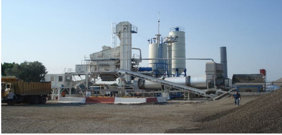
Resim 2. Kazınmış malzemesinin elenmesi ve plente beslenmesi
