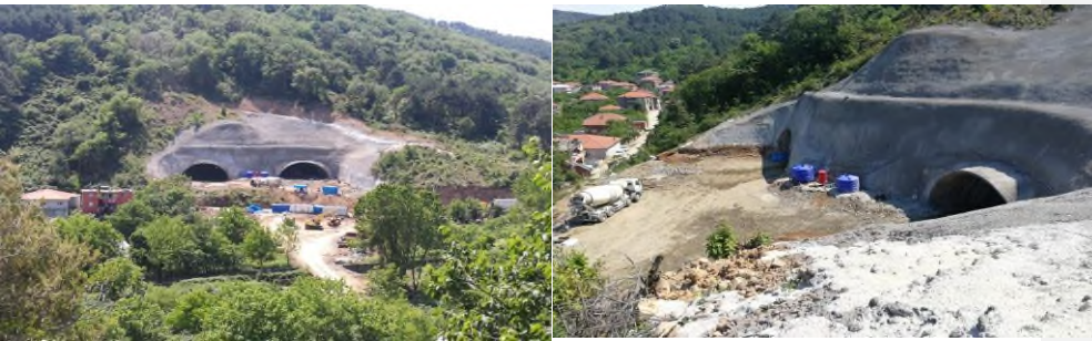
T-6 Tüneli Giriş Portalı
