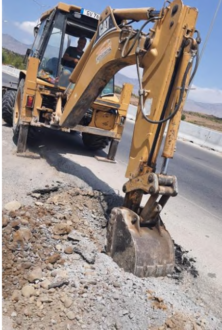
Üstyapı Araştırma Çukuru (ÜAÇ) Çalışmaları
